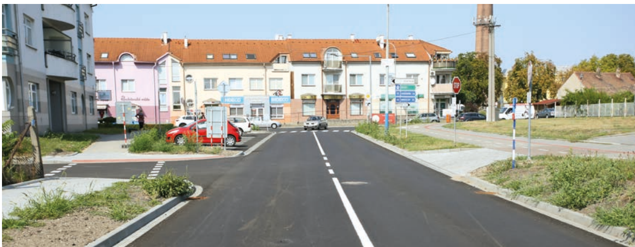
Ulice Na Zahradách prošla náročnou rekonstrukcí.
