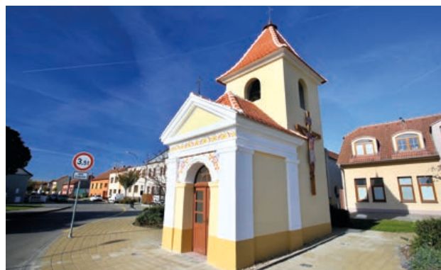
Oprava kapličky ve Staré Břeclavi.
