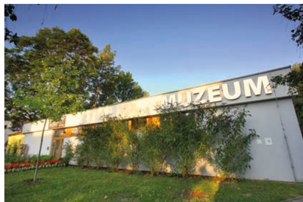
Budova MMG pod vodárnou.
